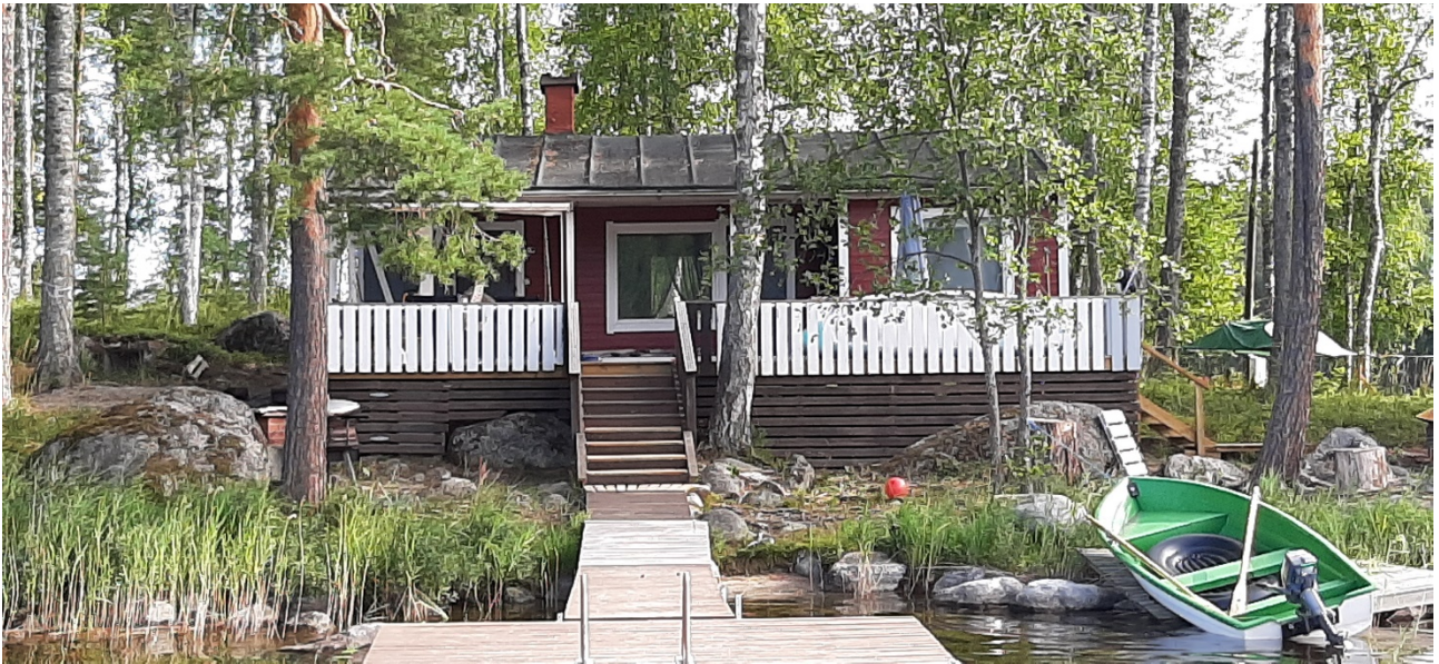
Kuva 3. Kilpuinsaaren eteläosassa olevan RA- rakennuspaikan lomarakennus.
